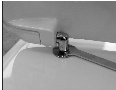
08 Stringere con la chiave in dotazione il fissaggio. Tighten the fixing screw by using the provided key.
