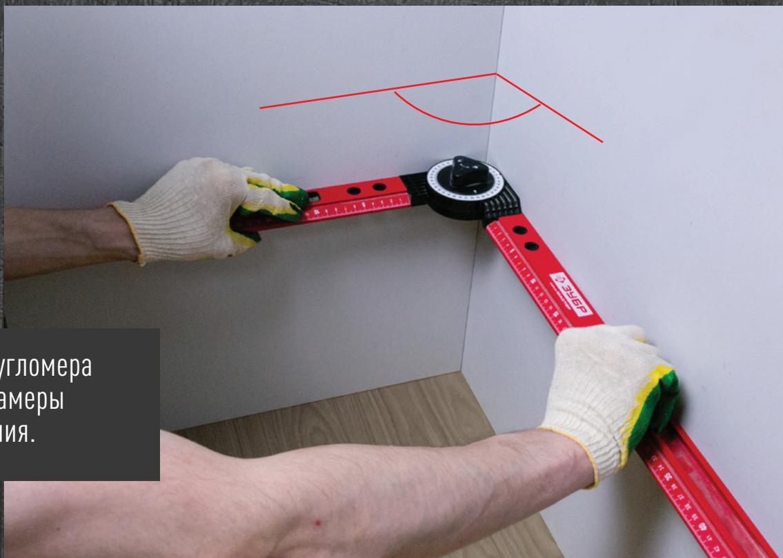
При помощи угломера произвести замеры угла помещения.
